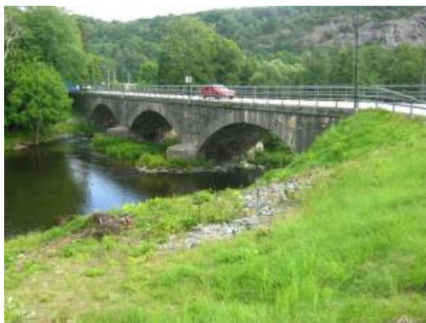
Kvistrums bro – en mycket vacker och välbyggd stenvalvsbro. Foto: Lars Gahrn.
